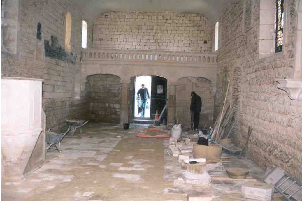
Vue générale de l'église, travaux en cours de finition.
